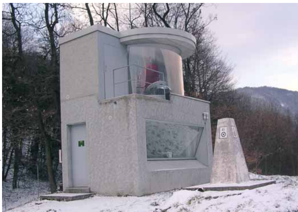
Local de Monfalcon hébergeant le distancemètre optique (au rez-de-chaussée) et le radar (à l'étage)
