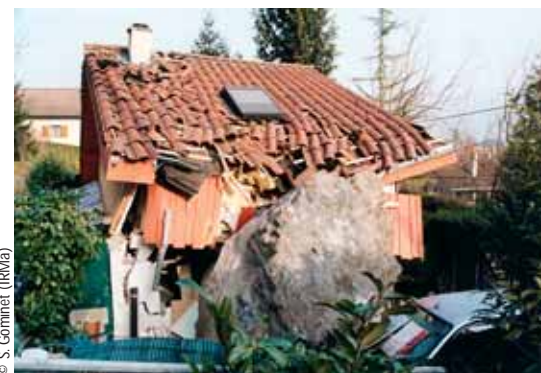
Destruction d'une maison à Lumbin (Isère) en janvier 2002 par un bloc provenant de la falaise surplombant la commune (versant Est du massif de la Chartreuse)
