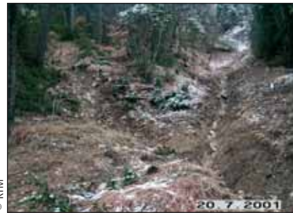
Un exemple de fossé
